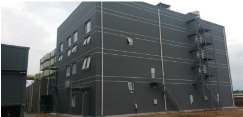
阿苏卫垃圾综合处理厂每小时处理30万立方米臭气的生物除臭塔
